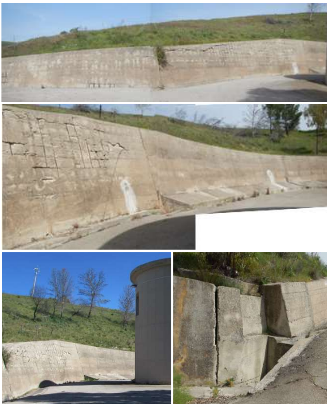
Figura 4.2: Diga di Gibbesi – Particolari dello stato di conservazione dei muri di sostegno a monte del piazzale
